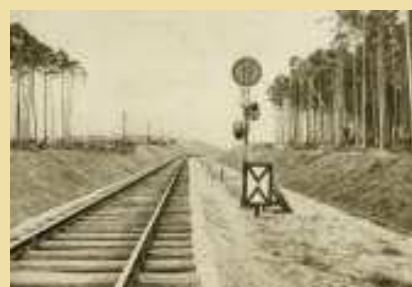
Fot. 1. Tory kolejowe w oryginale:
