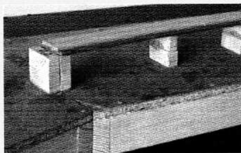
Fot. 6b. Szczegół podparcia torowiska w rejonie połączenia segmentów makiety (podpora podwójna).
