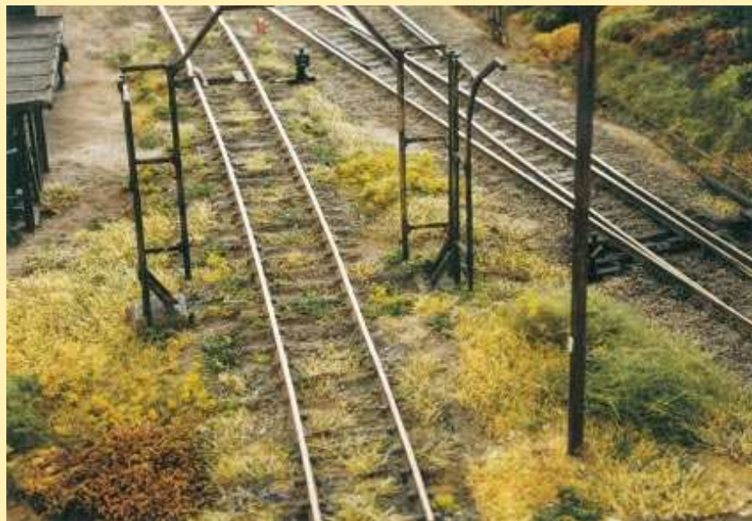
Fot. 2. Tor boczny dość silnie zachwaszczony.
