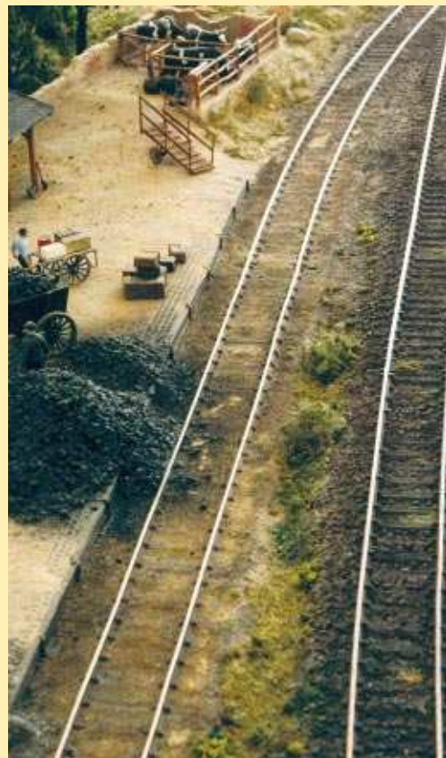
Fot. 1. Tor ładunkowy na podsypce żwirowej. Brak zachwaszczenia świadczy o jego należyтым utrzymaniu, zaś przebarwienia podsypki są efektem różnorodnych usypów z przeładowywanych materiałów.
