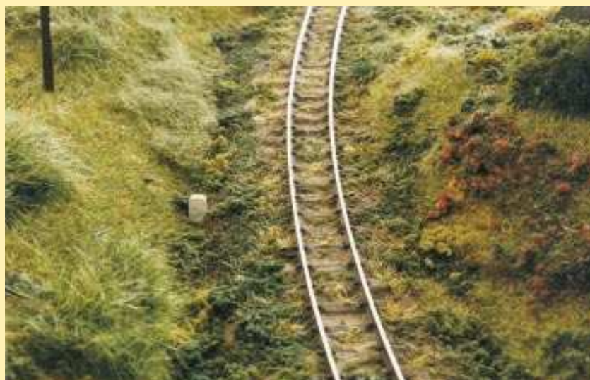
Fot. 3. Fragment szlaku kolei wąskotorowej. Charakterystyczne zachwaszczenia zwirowej podsypki i rowów bocznych wykonanych wzdłuż torowiska.
