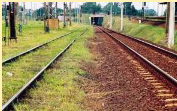
Fot. 4. Dwa tory główne: z lewej zachwaszczony, dawno nie remontowany; z prawej – czysta podsypka kilka lat po naprawie głównej.
