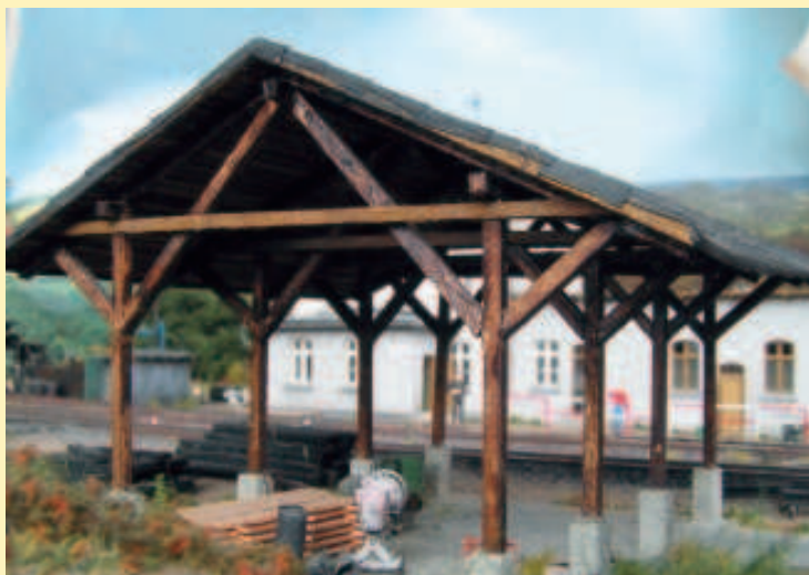
Fot. 3 Drewniana wiatra magazynowa
