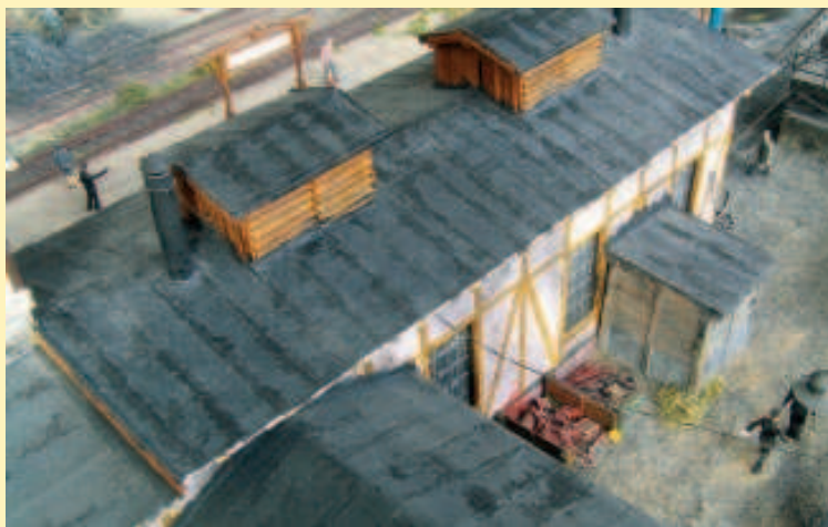
Fot. 1 Dach o konstrukcji drewnianej na jednostanowiskowej parowozowni
