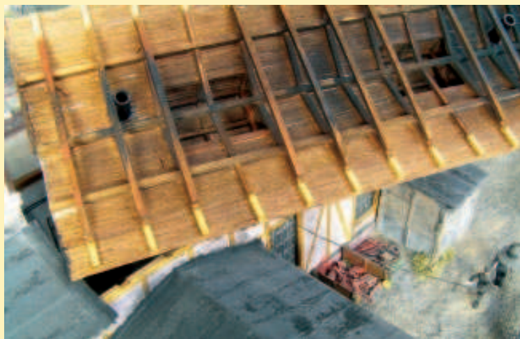
Fot. 2 Widok odtworzonej więźby dachowej (widocznej po uchyleniu dachu)
