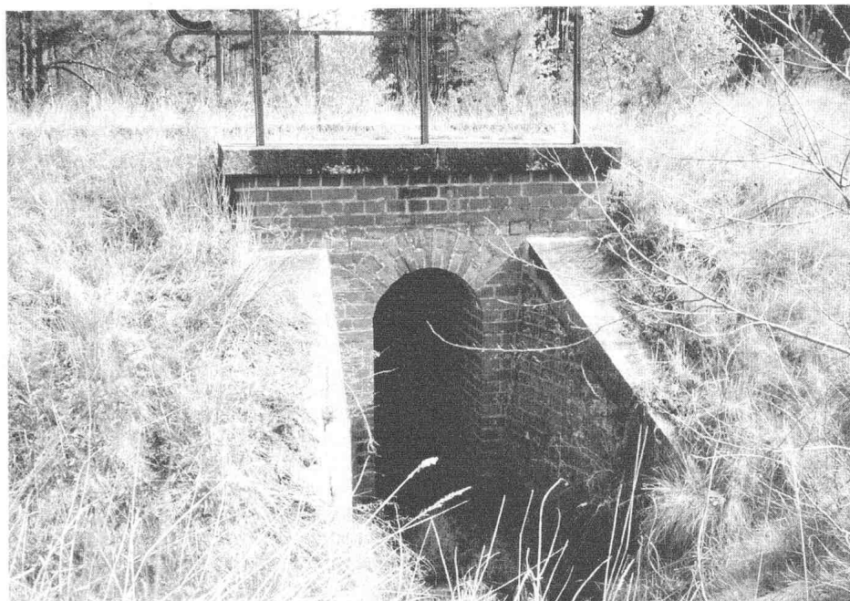
Ceglany przepust sklepiony w km 3,5 linii Konotop - Sulechów.
